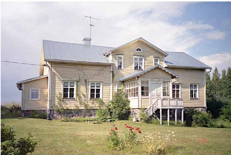
Kuva 11. Östergårdin tilan päärakennus Snappertunan pitäjän Torsön saaressa heinäkuussa 2000. Valok. Arno Forsius.
