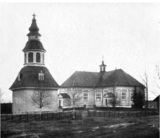
Kuva 5. Nurmijärven kirkko, jonka Mårten Tolpo piirsi vuonna 1783. Tarkemmin tuntemattomista syistä johtuen hän ei saanut kirkkoa rakentaakseen. Sen rakensi Matias Åkerblom vuonna 1793 ja tapulin hänen sisarenpoikansa Matias Åkergren vuonna 1794. Kirkossa on suoritettu vuosien mittaan useita korjauksia ja muutostöitä. Ristinmuotoisen kirkon harjalla oli alun perin keskiristin kohdalla kuvassa näkyvä pieni kattoratsastaja. Vuonna 1932 tehtyjen kunnostustöiden yhteydessä se korvattiin matalahkolla nivelikkäällä tornilla, jonka huipulla on ristiin päättyvä piikki. Kuvan lähde: Lindberg 1934.
