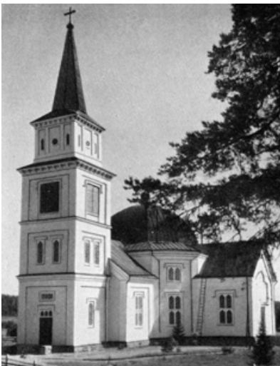
Kuva 19. Ruokolahden puukirkko, joka valmistui Theodor Tolpon rakentamana vuonna 1854. Kirkon on suunnitellut Ernst Bernhard Lohrmann. Se on keskeinen ristikirkko, jonka sisäkulmat on viistottu ja jonka neljällä sivulla on matalammat sakarat. Kuorin vastaiseen sakaraan liittyy korkea, solakkaan huippuun päättyvä torni. Uuden kirkon keskiosan kohdalla on ilman kaulaa oleva kupu. Kirkon valmistuttua vanha, vuosina 1740–1741 rakennettu kirkko purettiin, mutta sen vuonna 1752 rakennettu erikoinen, pohjaosastaan kahdeksankulmainen kellotapuli jätettiin jäljelle. Kuvan lähde: Lindberg 1934.
