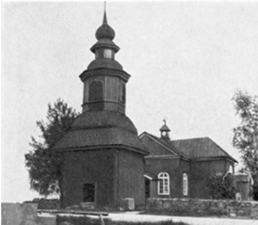
Kuva 8. Kosken Tl. vuonna 1817 valmistunut puukirkko oli ensimmäinen Magnus Tolpon itsenäinen kirkonrakennustyö. Sen suunnittelija oli Carlo (Charles) Bassi, ja se oli tasavartinen ristikirkko, jonka ristiharjalla oli hyvin pieni kattoratsastaja. Kirkon vieressä on nivelinen, pulleapäätteinen kellotapuli, joka oli valmistunut jo vuonna 1777. Kuvan lähde: Lindberg 1934.
