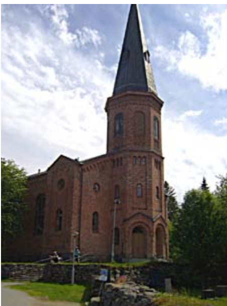
Kuva 22. Liperin punatiilikirkko, joka valmistui Theodor Tolpon rakentamana 1858. Sen piirustukset oli laatinut Turun ja Porin läänin lääninarkkitehti Georg Theodor Policron Chiewitz vuonna 1852. Kirkko edustaa muotiin tullutta uusgoottilaista tyyliä ja on rakenteeltaan pitkäkirkko, jonka kummassakin päädyssä on molemmin puolin kapeat päädylliset sakarat. Läntisessä päädyssä on kahdeksankulmainen, pitkään huippuun päättyvä torni. Valok. Riitta Mäntylä, Liperi (kuvaajan julkaisulupa vaaditaan).
