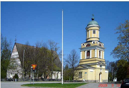
Kuva 9. Magnus Tolpo voitti kesällä 1828 urakan kellotapulin rakentamiseksi Hollolan keskiaikaisen kivistä kirkon eteläpuolelle. Rakennuspiirustukset oli tehnyt Carl Ludwig Engel. Tapulin pohjakerroksen keskiosa ja sen päällä oleva nelikulmainen osa on rakennettu harmaakivistä. Puusta tehdyssä yläosassa on jalustamainen alaosa ja sen jatkeena on pyöreä yläosa ja kupukatto. Pohjakerroksen sivuilla on tiilestä muuratut sivuosat, joista kuvassa edessä näkyvä toimi inventaariovarastona ja toisella puolella oleva osa ruumiiden säilytys- ja avaustilana. Tapuli oli samalla
