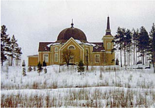
Kuva 18. Rääkkylän puukirkko, jonka Theodor Tolpo rakensi vuosina 1849–1851. Kirkon on suunnitellut valtion intendenttikonttorin (rakennusvirasto) johtaja Ernst Bernhard Lohrmann. Ristimäisen kirkkokuoneen sisänurkat on viistetty ja läntisen kuorisakaran jatkona on solakkaan huippuun päättyvä torni. Kirkkokuoneen keskellä on suuri, kaulaton kattokupu. Kuvan lähde: Jarl Pousarin keräämä Tolpo –arkisto.
