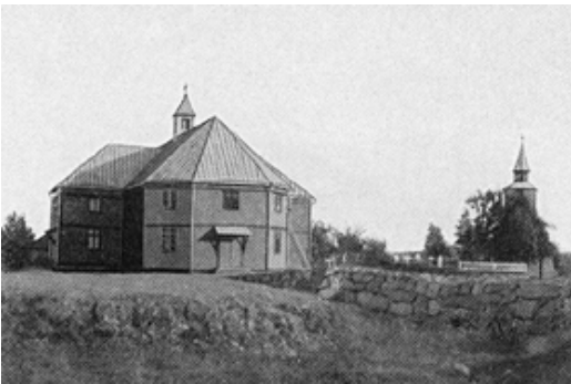
Kuva 3. Vesilahden kirkko ja vuonna 1782 rakennettu kellotapuli. Vesilahden kivistä rakennettu kirkko paloi vuonna 1602. Seuraava kirkko pystytettiin n. vuonna 1655. Siitä luovuttiin, kun kuvassa näkyvä, Mårten Tolpon vuosina 1801–1803 rakentama kirkko valmistui. Uudessa kirkossa on pitkä, suorakaiteen muotoinen runkokuone, jonka kulmat on viistottu. Molemmilla sivuilla on hieman matalammat ristivarret. Kirkon ikkunat ovat kahdessa kerroksessa. Harjan keskellä on pieni kattoratsastaja. Kuvan lähde: Lindberg 1934.
